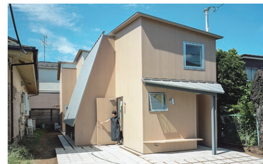
野地木材の杉板材を使用した o+h 設計「世田谷の家」
